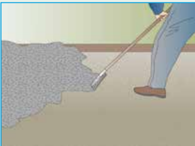
Mettre en place la couche support, constituée de terre et de graviers mélangés et concassés.
