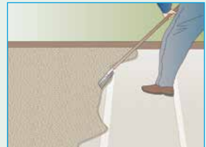
Sur le géotextile, déposer le mélange pour gazon constitué de cailloux concassés et de sable. Cette couche doit être perméable à l'eau.
