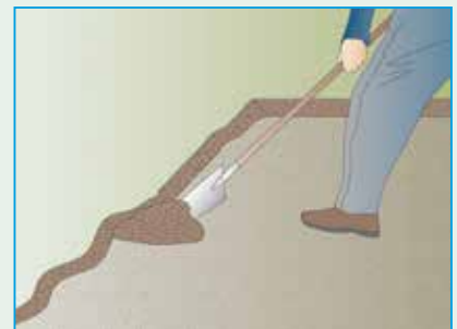
Décaisser le terrain, en retirant une vingtaine de centimètres de terre.
